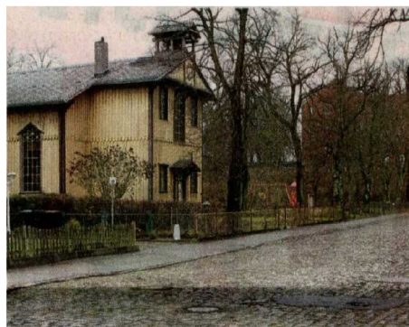
In Alt-Friedrichsort, wo die Bethlehemkirche steht, ist das alte Straßenpflaster mit Asphalt geflickt. Die Gutachter empfehlen, dies zu ändern.
