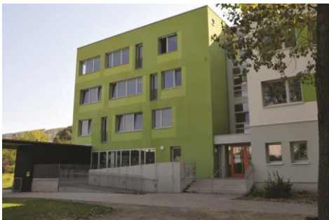
Erweiterung, Sanierung und Umbau zu einer Quartiersschule, Karl-Friedrich-Friesen-GS
